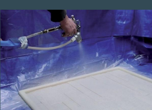
工人正在将A1三轴纤维涂覆在模具上。
