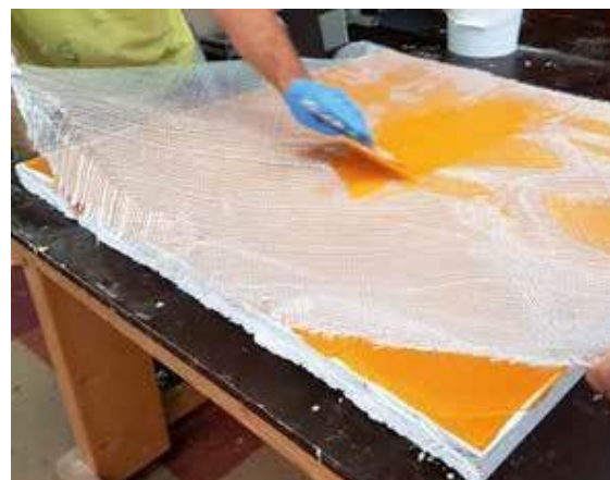
在应用 A1 三轴光纤之前，首先将其切割成尺寸，给定 A1 的处理时间。
