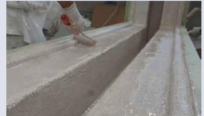
所有加固层都以相同的方向堆叠。
