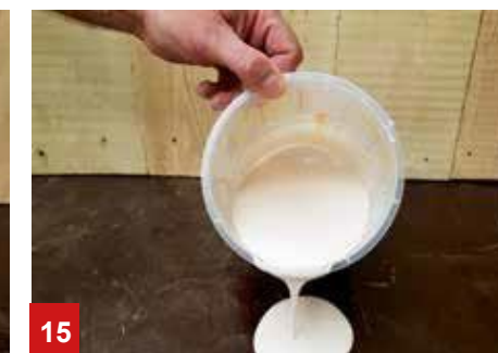
12 搅拌混合器直至所有团块消失（±1分钟），得到光滑的材料。
