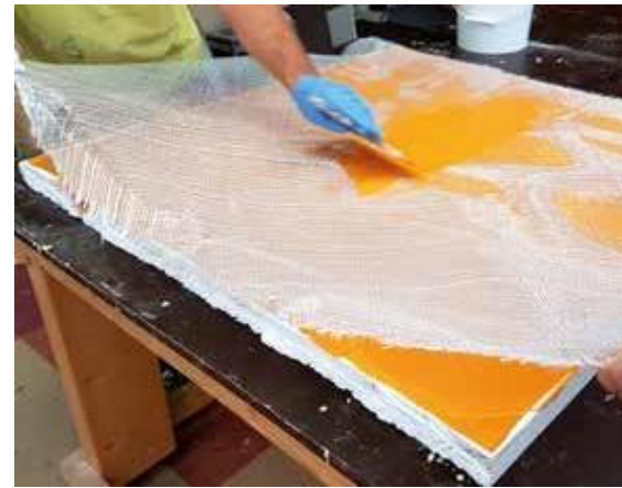
给定A1的处理时间, 在应用A1三轴纤维之前, 请先将其切成一定尺寸。
