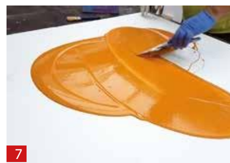
7 用刮刀在EPS上涂一层薄薄的A1。
