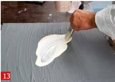
13 用刷子在表面上涂一层薄薄的A1。
