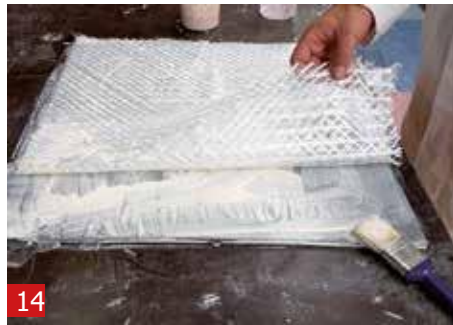
14 在表面上涂抹一块与物体大小相同的三轴纤维，并从中心用刷子将其弄平。
